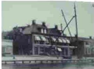
De gevel van de mastmakerij houdt de mast met laadboom als het ware vast: een ijzeren buis strekt zich uit boven de straat. Dubbele touwen dienen ervoor de top van de laadboom boven het water of boven de wal te manoeuvreren 7
